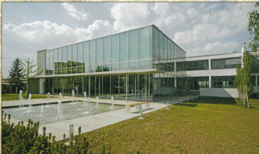
Repräsentatives Ausstellungsgebäude der FERMO Massivhaus AG, in Murr bei Stuttgart. Trotz Südseite ohne außenliegenden Sonnenschutz.
